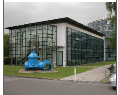
Das umgebaute und integrierte Altgebäude der Stadtwerke
