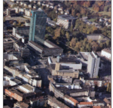
Hagens Innenstadt mit dem alten Sparkassenhochhaus-Abriss 2004
