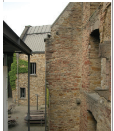
Blick in den Innenhof von Haus Witten, Alt und Neu trifft spannungsvoll aufeinander
