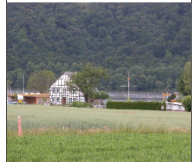
Haus Baukey, mit den Gebäuden des Yacht-Club Harkortsee Foto: LWL/Christine Bonatz
