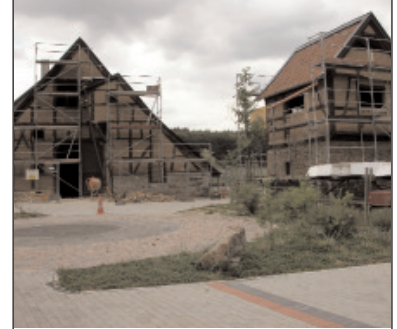
Haus Baukey, Wirtschaftsgiebel und Kornspeicher in der Bauphase Foto: LWL/Christine Bonatz
