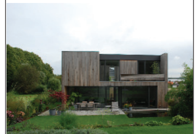
Ansicht von Westen, Haus B II
